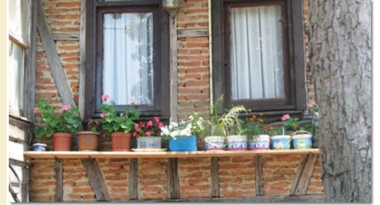
Paşalar Köyü Ahşap Çatkılı Tuğla Ev
