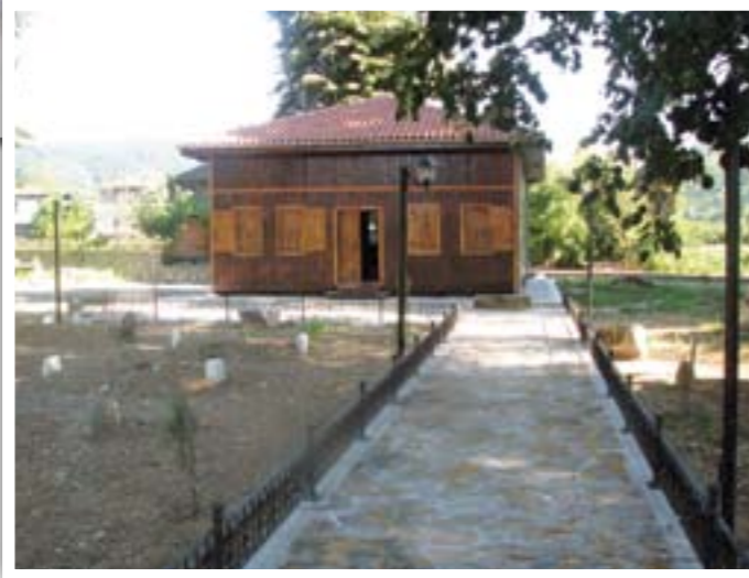
Çayağzı Köyünde Restorasyonu Tamamlanmış Orhan Gazi Camii
